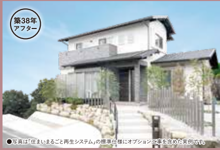
●写真は「住まいまるごと再生システム」の標準仕様をオプション工事を含めた実例です
